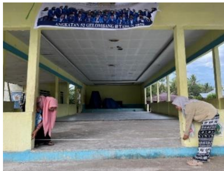
Gambar 3. Tahap Pengukuran Bangunan Eksisting
