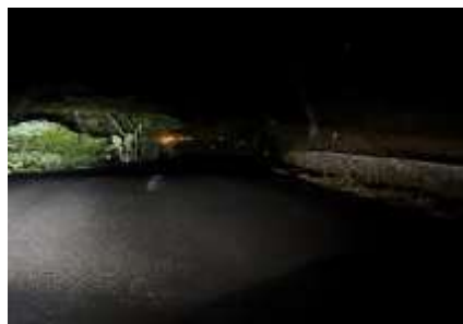
Gambar 8. Kondisi Ruas Jalan Dengan Penerangan Terbatas Sebelum Pemasangan Reflektor
