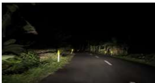
Gambar 11. Hasil Pemasangan Reflektor Jalan
