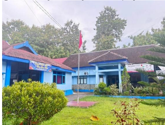
Gambar 1. Kantor Dinas Perumahan, Kawasan Permukiman, dan Perhubungan Kabupaten Trenggalek Sumber: Dokumentasi kegiatan, 2026
