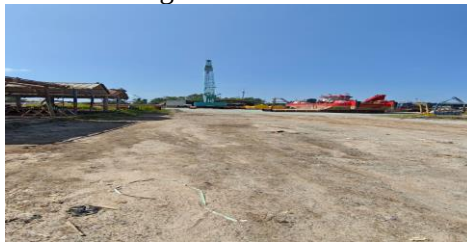
Gambar 1. Kondisi area terbuka pada kegiatan pekerja di lokasi lifting
